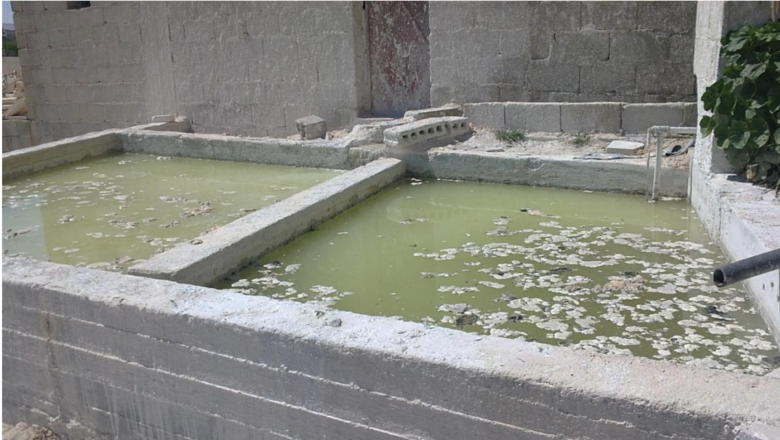
الصورة ( 9 ) نمو الطحالب.
